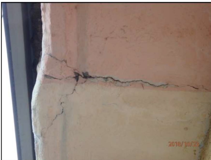
Styk balkonových panelů v místě sloupku, zespod (2 případy + detail)
